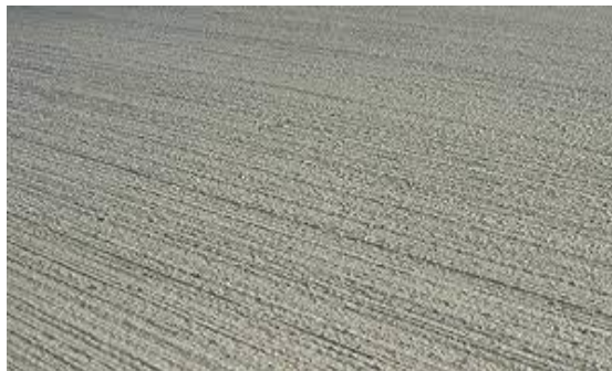
Fotografia do acabamento do piso
