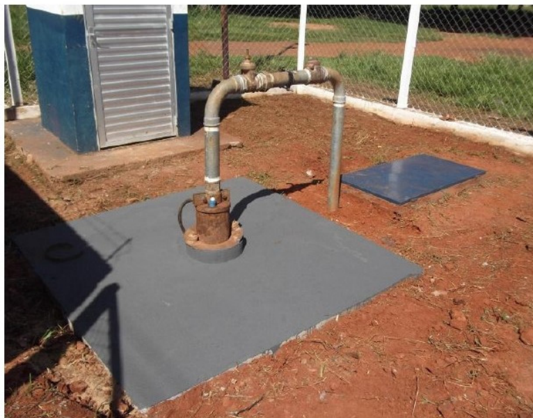
FOTO 3. Laje de proteção para poço artesiano.
